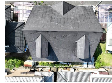
屋根：ドローン調査
