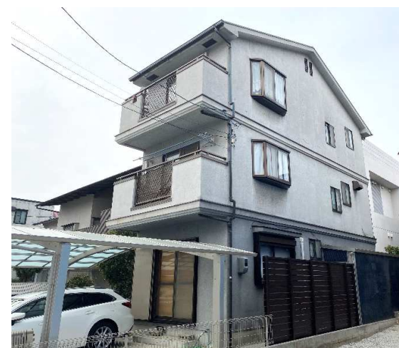
バルコニー設置前
