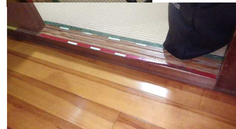
着工前 廊下と和室の床は約5cmの段差がありました
