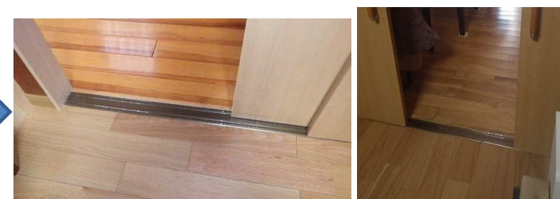
施工後 和室の床を下げ、建具のレールをフラットレールにして段差を無くしました。リビングとの建具(右)も同様に移動しやすくなりました。
