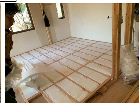
床 写真に見える吸音ウールの上に3層 合板12mm+遮音マット9mm+床下リッパ12mm
