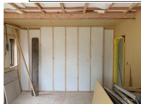
壁・天井 写真に見える吸音ウールの上に3層 壁：石膏ボード12.5mm+遮音パネル10mm+オトカベ(吸音)12.5mm+仕上げ材(珪藻土) 天井：石膏ボード12.5mm+遮音パネル10mm+オトデン(吸音)12.5mm
