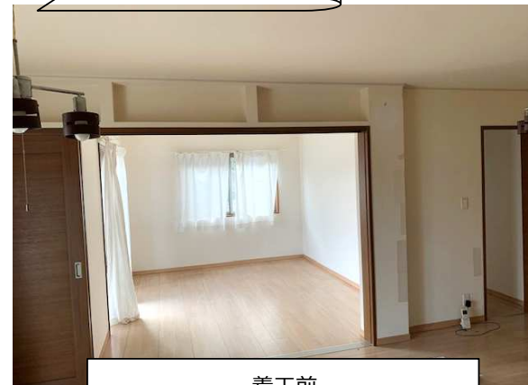
着工前 正面の洋間(7畳)と右奥の納戸(3畳)を一間(10畳)にして、防音室にします。
