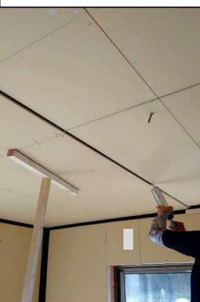
気密遮音コーキング パネルの隙間も、充填剤を注入。ジョイントボックスにもパテ材を入れて音漏れを防ぎます
