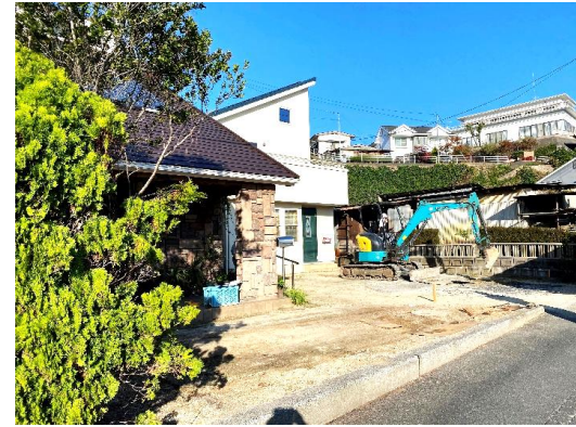
着工前(これから地面を掘ります)
