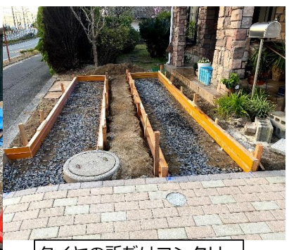
タイヤの所だけコンクリートで仕上げるので、型枠を立てています
