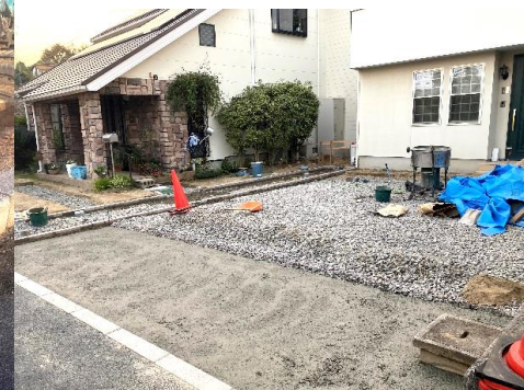
手前側は、下地コンクリート10cmの上にインターロッキング施工します
