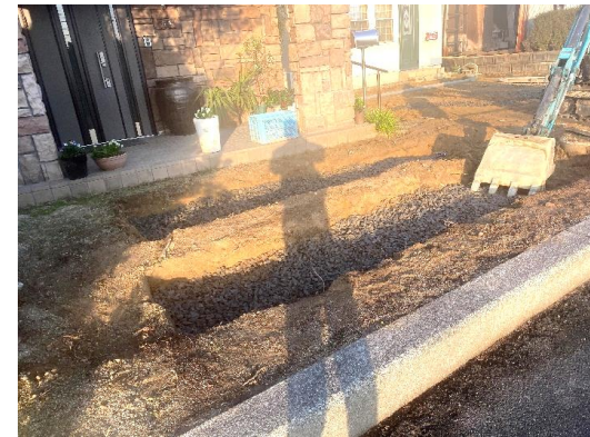
20cm床掘をして、10cm碎石を入れているところ
