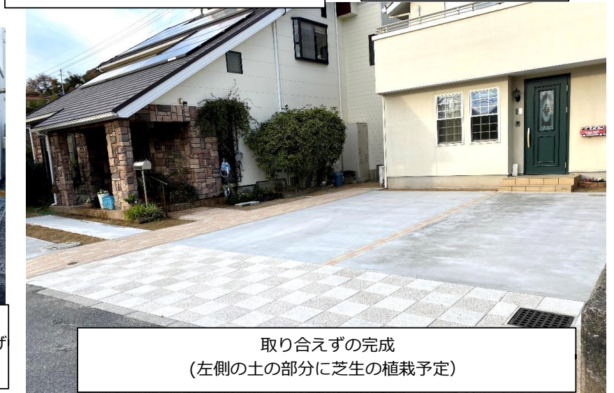
手前側は、下地コンクリート10cmの上にインターロッキング施工します
