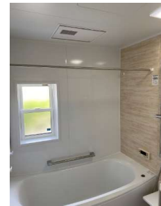
断熱仕様のユニットバスに換気暖房機を付け、窓も複層ガラスの断熱サッシに取替え寒さ対策は完璧です！
