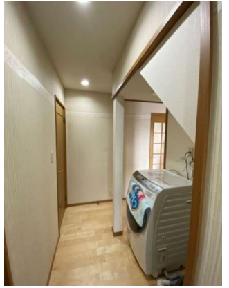
使い勝手が悪かった階段下収納部を廊下スペースに取り込み洗濯機置き場としました。壁を取り払ったことでとても明るくなっています。
