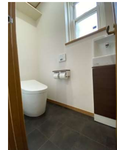
タンクレス便器に取替え、手洗い器を新設。窓も断熱サッシに取替えて、寒さ対策しています。
