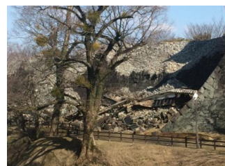
崩れた石垣がそのままの熊本城
