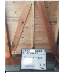
増設した耐力壁
