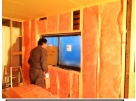
断熱施工状況
