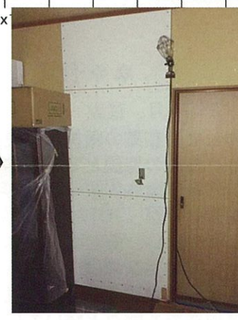
②補強ヶ所に耐力面材を施工
