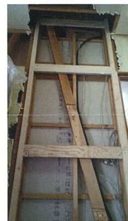
①既存壁を撤去
