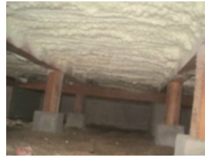
断熱改修状況 床下:発泡ウレタンフォーム
