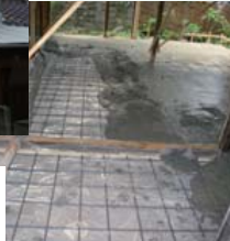
土間をコンクリートで基礎補強
