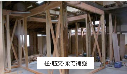
土間をコンクリートで基礎補強
