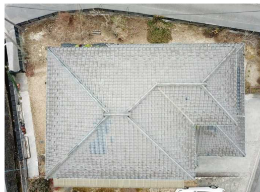
上空20mから撮った屋根全体写真
