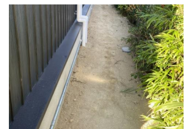
基礎補強(完工)
