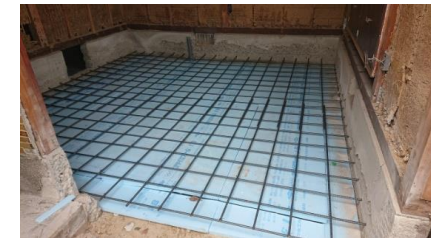
土間補強(施工状況)
