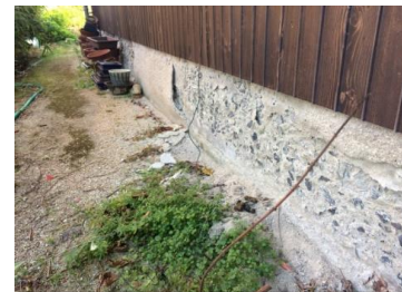
基礎補強(着工前)
