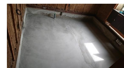
土間補強(完工)
