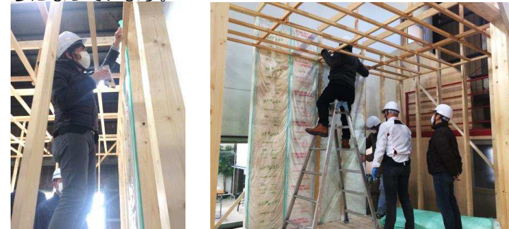
断熱施工研修の様子
