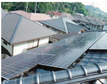
パネル設置状況
